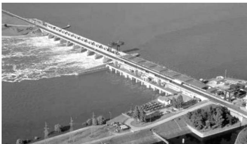
Rysunek 4. Elektrownia wodna przepływowa w Żyrardowie
