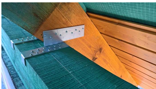
Zdj. 1 Połączenie krokwi i murlaty
