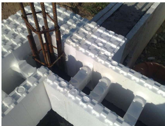
Zdj. 2 Ściana ze styropianowych bloczków szalunkowych
